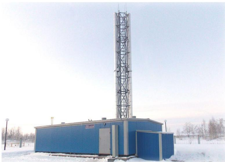
Блочная котельная установка КБТа предназначена для организации горячего водоснабжения и теплоснабжения жилых зданий и сооружений различного назначения больших площадей – от 5000 до 200 000 кв.м. Её работа осуществляется в автоматическом режиме с полным контролем отпускаемого тепла, потребляемой электроэнергии и газа. Работа установки не требует присутствия и контроля со стороны обслуживающего персонала.
